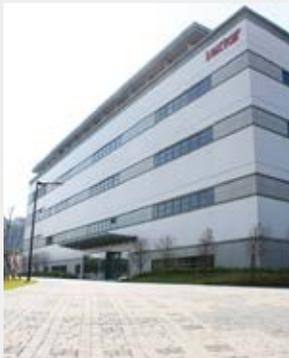
新竹總部獲全國第一座綠建築黃金級LED廠房認證以「三大生態平衡」手法設計，戶外鋪設透水再生磚，使雨水能滲入土壤、回歸大自然。
